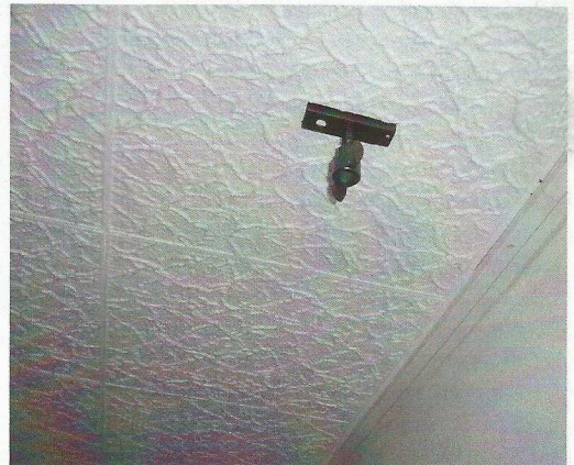
An die Decke kamen 2 cm dicke Styroporplatten, der Beamer-Halter wurde sauber darin eingearbeitet.
