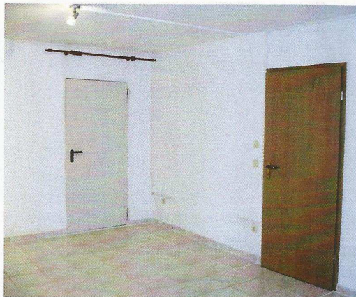
Startpunkt: Noch sieht im Keller nichts nach Heimkino aus. Die Fußbodenheizung verrichtet aber schon ihren Dienst.
